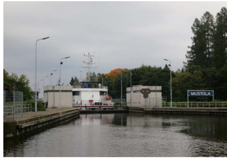
Mustolan sulkusilta. Vuonna 2011 Saimaan kanavan kautta kulki yli 42 000 matkustajaa ja 1,76 miljoonaa tonnia tavaraa (Lähde: SVT/Kanavaliikenne). (MV).
