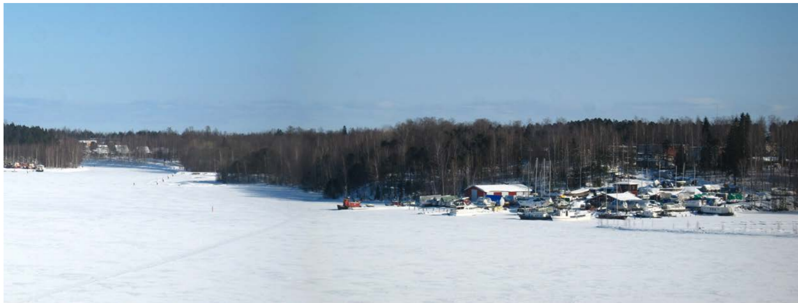
Näkymä Luukkaansalmen sillalta Kanavansuun ja Lauritsalan sataman suuntaan. (A-KA)
